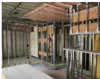
通電前の屋内作業に
