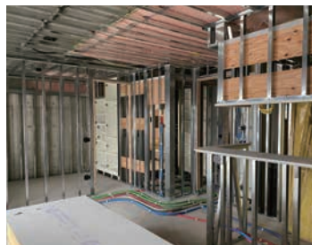
通電前の屋内作業に
