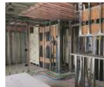
通電前の屋内作業に
